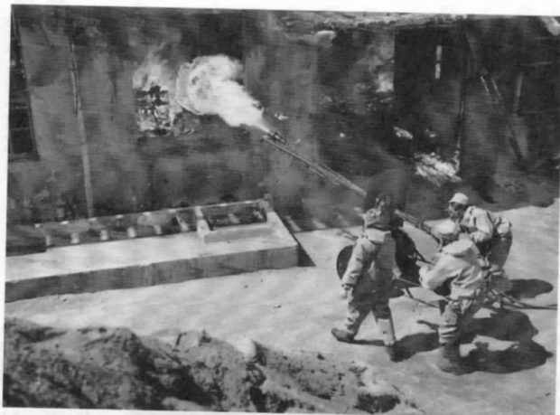
長浦毒ガス貯蔵庫での火炎放射器による除染作業(1947年3月20日撮影、オーストラリア戦争記念館コレクションより)
